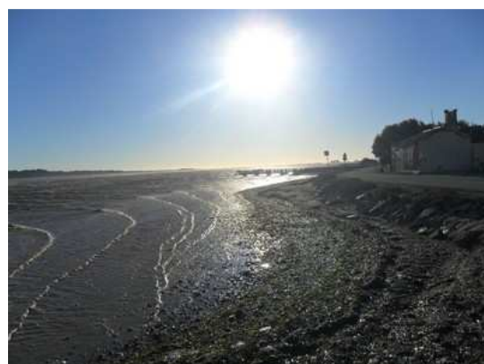
Photo du jour : érosion de la plage de Port-Mahon
